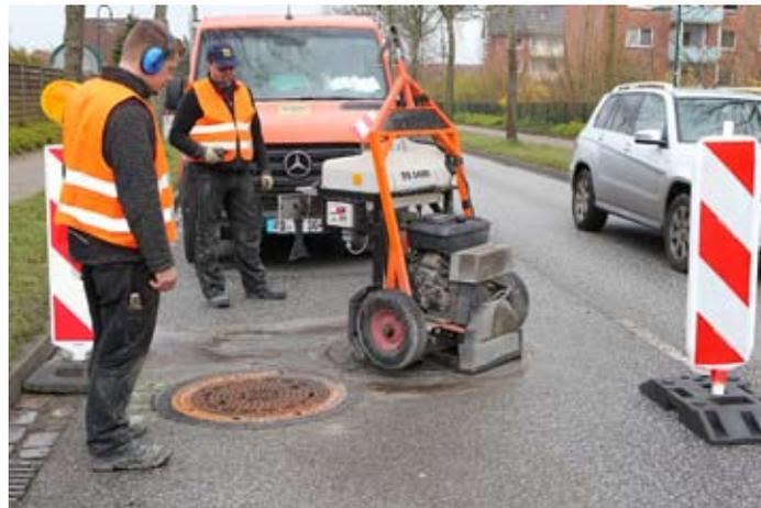
Eine Schachdeckelfräse schneidet ein kreisrundes Loch in den Asphalt zentrisch um den vorhandenen Schachdeckel. Sascha Koller (l.) und Carsten Matthiessen beobachten den Vorgang
