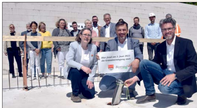
Grundsteinlegung: Bürgervorsteherin Maike Wilken, Bürgermeister Rainer Hinrichs und Schulleiter Martin Seifert (von links) versenken die Zeitkapsel in einem Loch im Betonboden.
