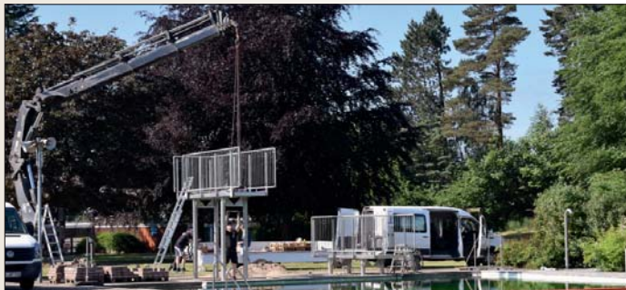
Die neue Sprunganlage mit Ein- und Drei-Meter-Brett.
