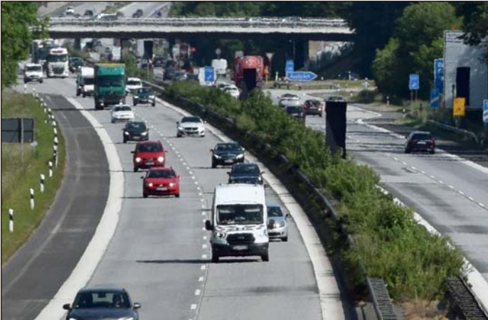
Nicht diese Autobahn-Brücke wird vom 16. Juni (20 Uhr) bis 19. Juni (5 Uhr) abgerissen, sondern die zwischen Büdelsdorf und Owschlag.
