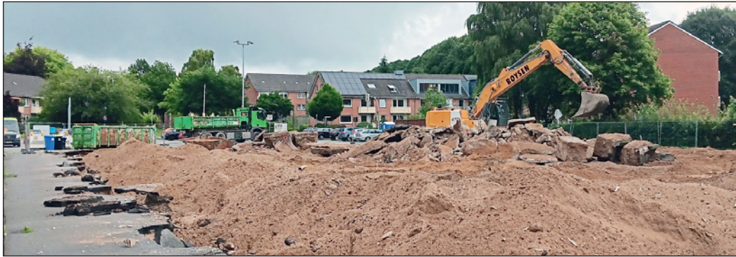
Nach dem Abriss des ehemaligen Edeka-Marktes: Freie Sicht vom Wendehammer der Wilhelmstraße auf die Berliner Straße / Weichselstraße.
