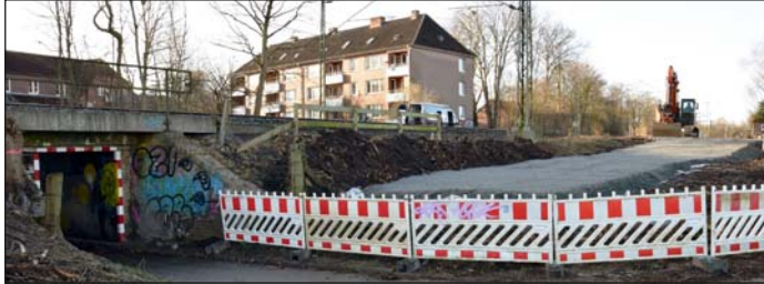
Die Baustraße vom Bahnübergang Eckernförder Straße ist fertiggestellt.
